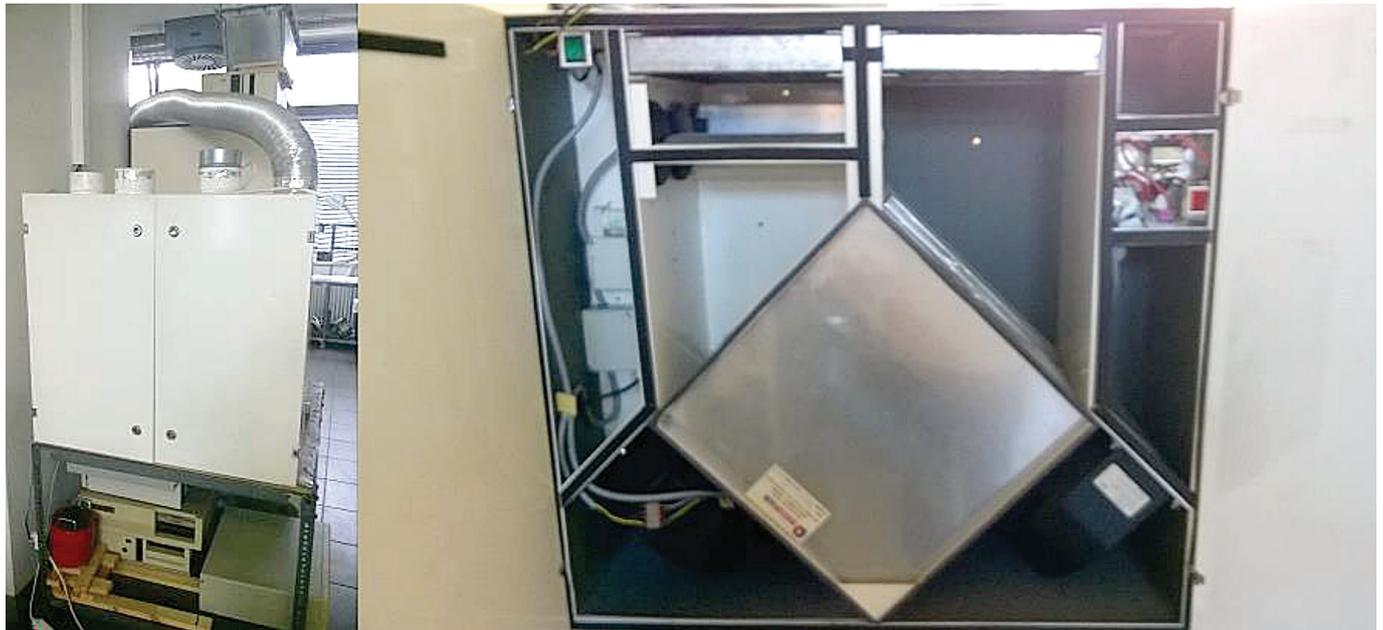
Fig. 3 Air handling unit
